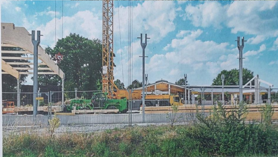
Laut Oberverwaltungsgericht ist der Baustopp an der Haller Straße in Holtkamp rechtmäßig. Seit September passiert nichts mehr auf der Baustelle.
