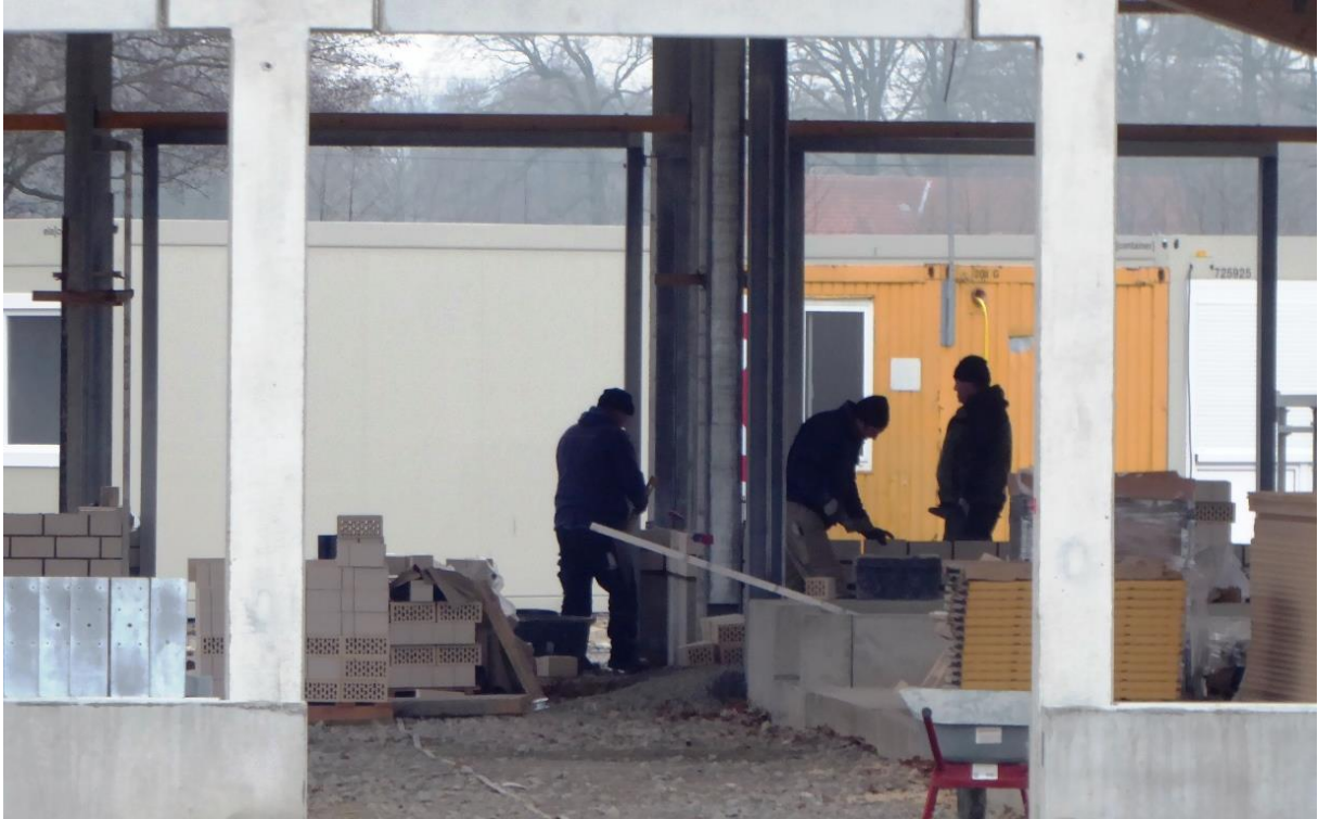
14.12.2021, Ca. 11:00 Uhr: Maurerarbeiten für eine Mauer der Pferdeställe
