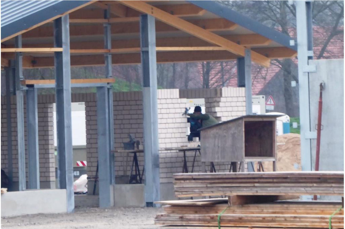
14.12.2021, ca. 16:00 Uhr. Maurerarbeiten in den Gebäuden des Pferdestalls. Im Laufe des Tages wurde eine komplette Mauer neu aufgemauert.
