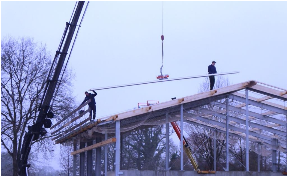
15.12.2021, ca. 11:00 Uhr: Die Dacheindeckungsarbeiten werden fortgesetzt
